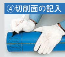
継手の融着面の範囲に油性ペン等でマーキングします。
