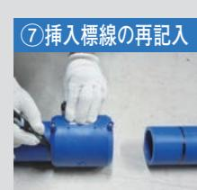
管に継手を奥まで挿入し、EF継手端部を利用して再度挿入標線を記入します。
