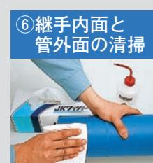
アセトン等を浸み込ませたペーパータオルを使用して融着面を清掃してください。挿入標線を再度記入してください。
