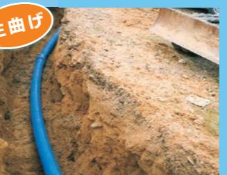
柔軟性があり、生曲げ配管により継手の数を減らせます。
